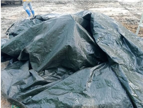
รูปที่ 4 การคลุมกองดินด้วยผ้าใบ
