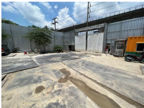
รูปที่ 1 รั้ว Metal Sheet สูง 6 เมตร รอบแนวเขตพื้นที่โครงการ
