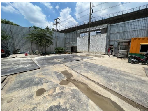
รูปที่ 9 การปูแผ่นเหล็กในพื้นที่โครงการ
