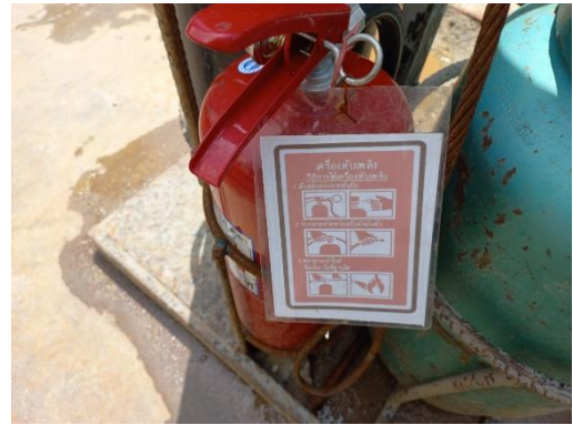
รูปที่ 19 ถังดับเพลิงเคมี พร้อมป้ายแนะนำการใช้งาน
