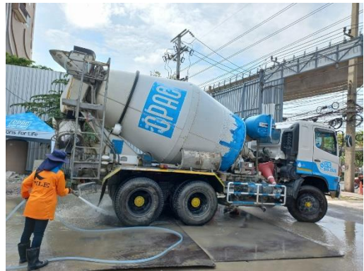
รูปที่ 8 การทำความสะอาดล้อรถก่อนออกนอกโครงการ
